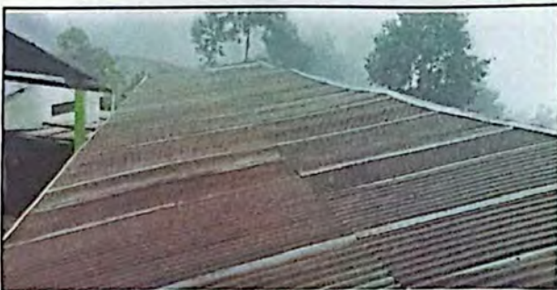
Foto 5: la lamina ya esta deteriorada por el paso del tiempo y tiene que ser reemplazada.
