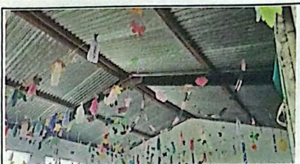
Foto 3: los soportes de las laminas no son las adecuadas para el peso de las mismas.
