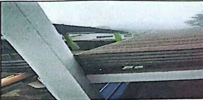
Foto 6: los canales de la bajada de agua no son las indicadas y tiene que ser reemplazada.
